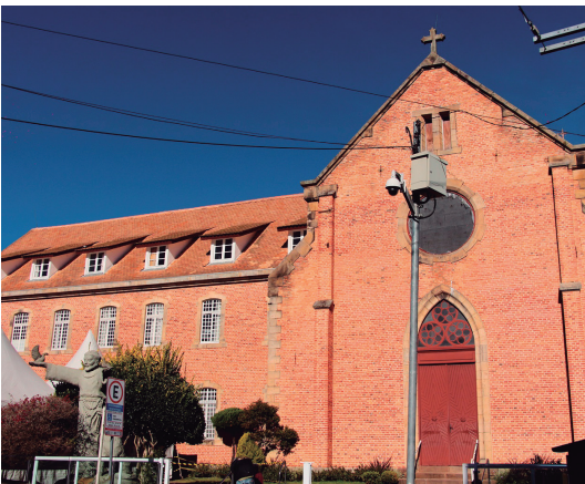
Preservação Convento Franciscano passa por restauro 4
