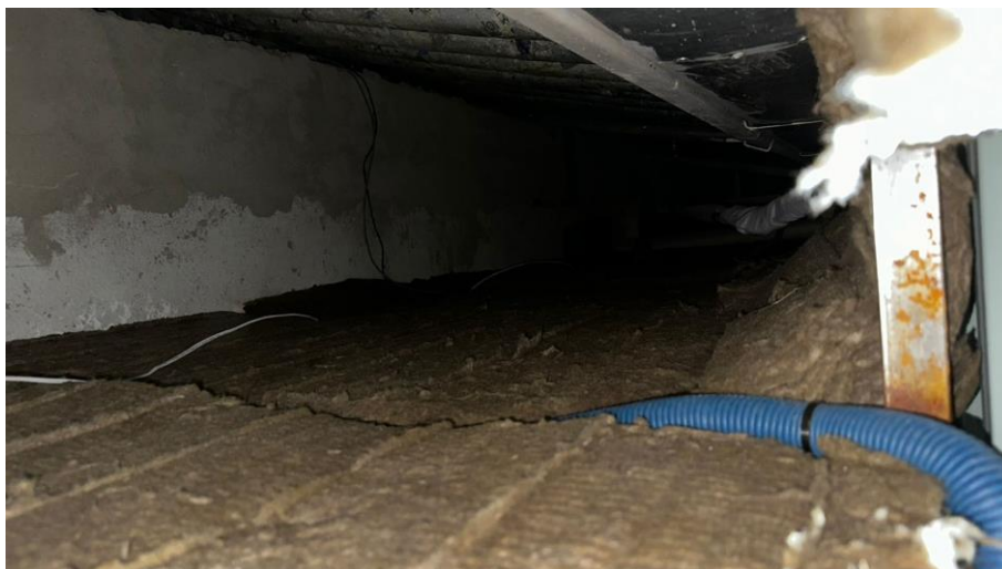
Foto 10: instalação do painel da la de rocha. ( autor)
