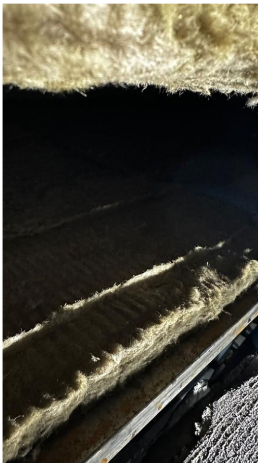
Foto 14: instalação do painel da la de rocha. ( autor)
