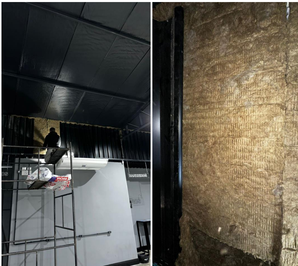
Foto 12,13: instalação do painel da la de rocha. ( autor)
