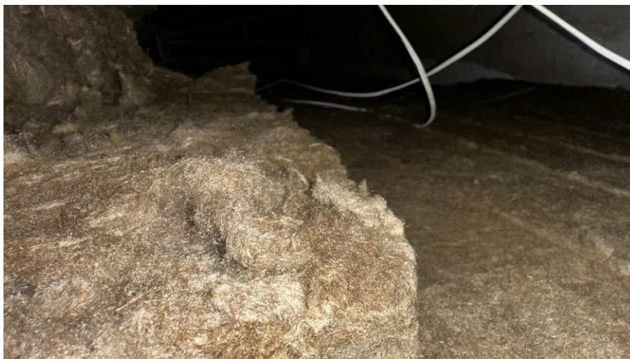
Foto 09: instalação do painel da la de rocha. ( autor)
