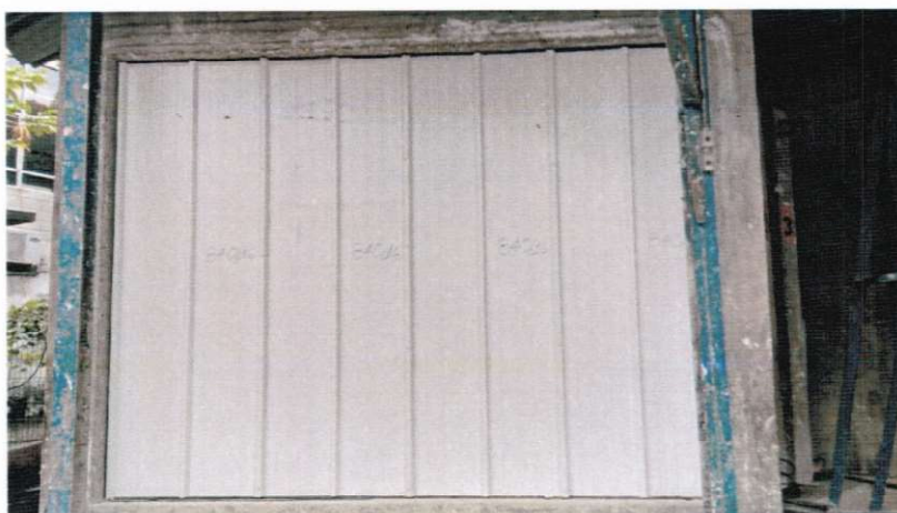
Figura 4: Corpo de prova instalado no pórtico
