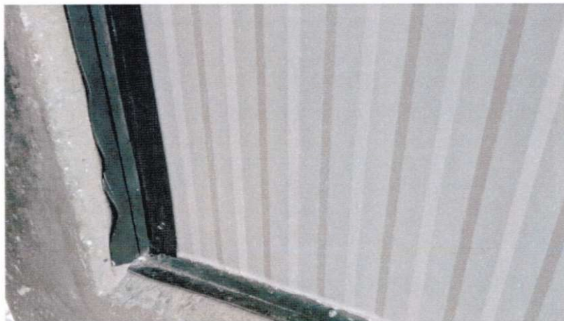
Figura 3: Fixação das telhas no pórtico de ensaio e fechamento das juntas com manta de borracha preta e silicone
