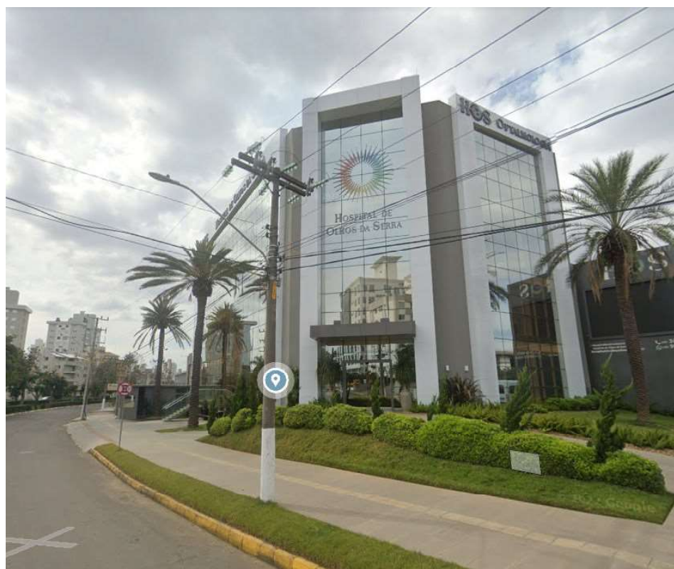
Figura 06 – Hospital de Olhos da Serra
