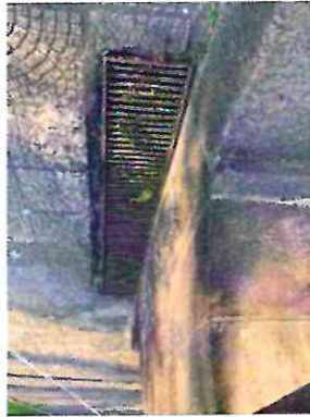
Figura 08 – Coleta de água pluvial (Existente) aos fundos do monumento, a jusante do lago do parque.
