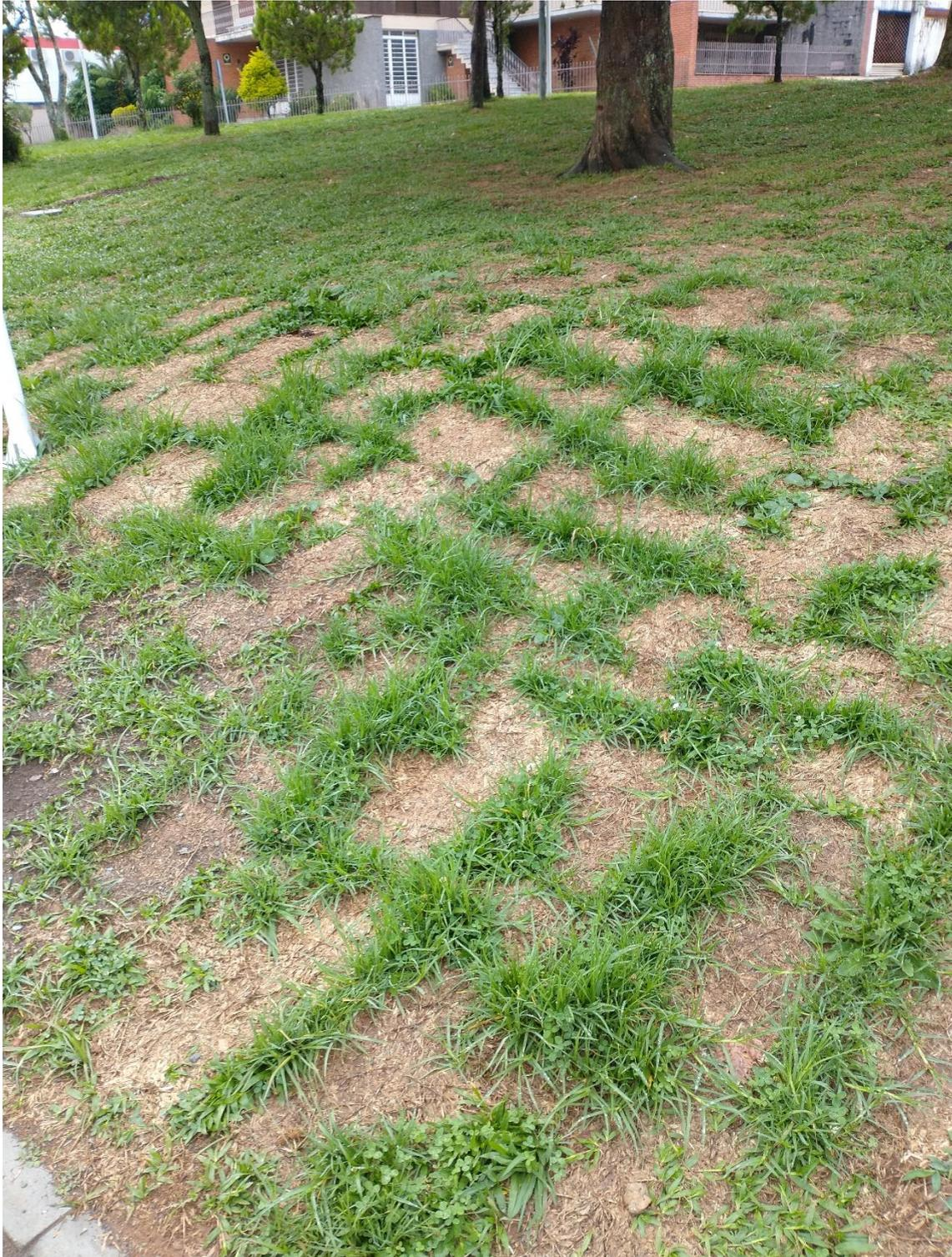
Na imagem acima é possível ver que a grama foi plantada sem a retirada do material existente. Sequer foi feita a limpeza da área com a retirada do mato. Ademais, a grama foi plantada morta.
